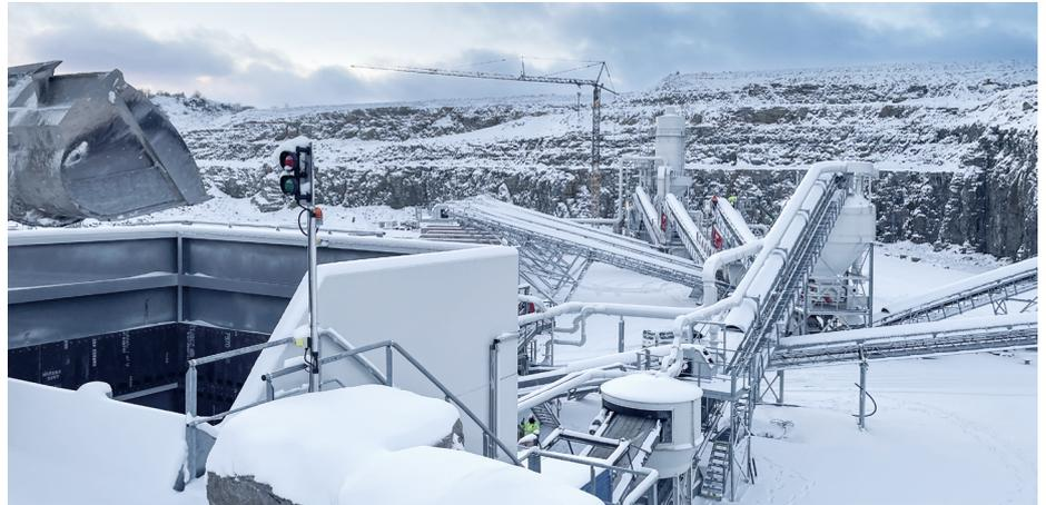
Die neue stationäre Aufbereitungsanlage ersetzt die dieselbetriebenen mobilen Brecher und Siebmaschinen. Ihr Energiebedarf wird zunächst durch grünen Strom aus Wasserkraft gedeckt und mittelfristig durch selbst erzeugten Solarstrom aus der geplanten Photovoltaik-Anlage. © Mineral Baustoff GmbH
