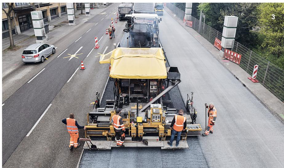
**2** ClAir® Asphalt-Einbau mit Innovationsfertiger und -bunker in Erlangen.
