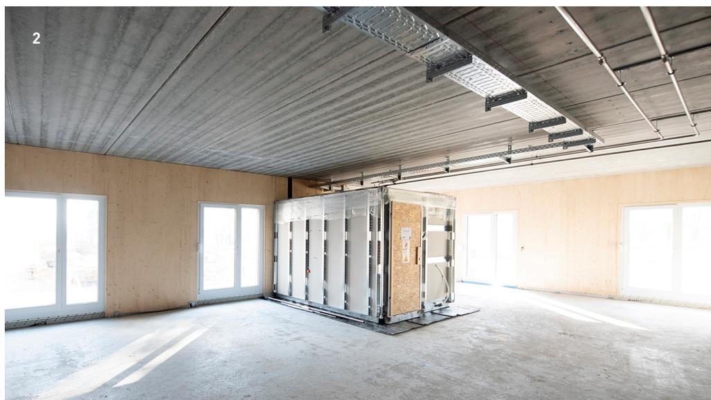
2 Die Nasszelle ist bereits eingesetzt. / 3 Teamarbeit beim Einsetzen der Außenwände. © Sandra Sitzmann
