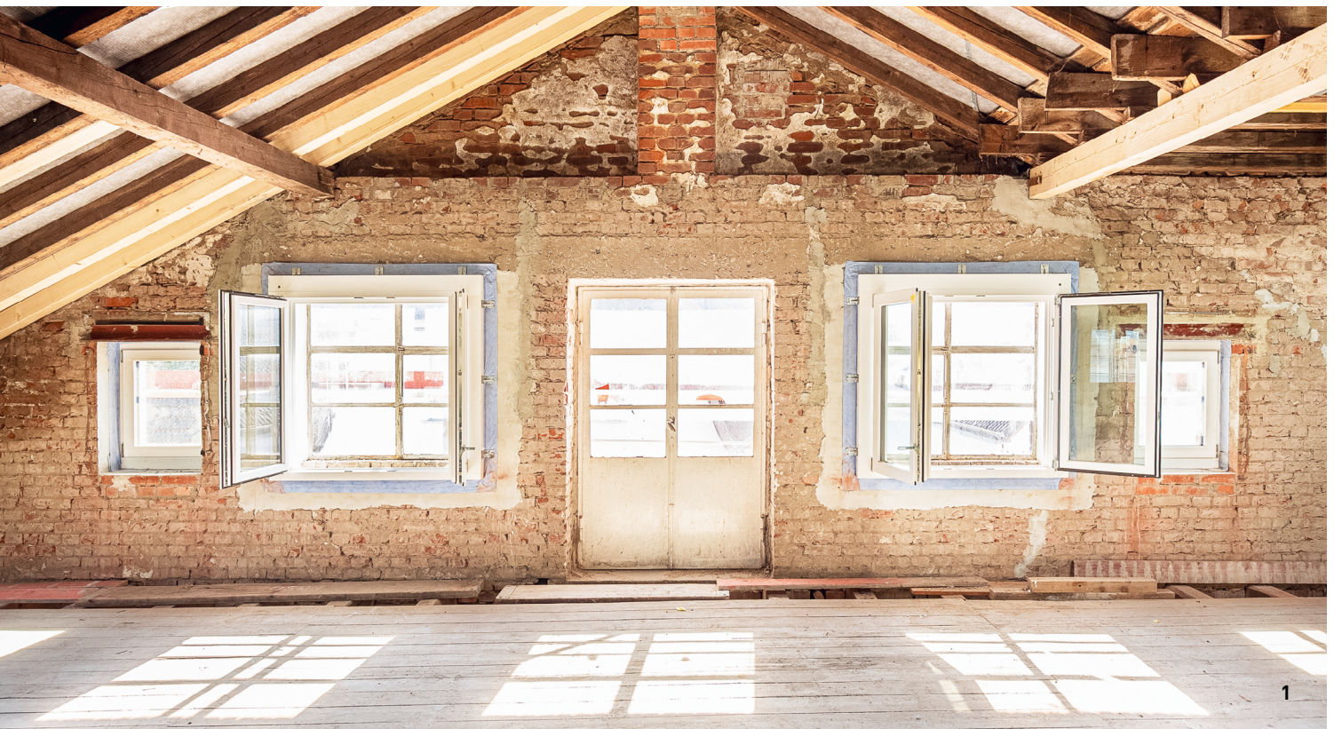
1 Die Kombination aus den historischen Stahlfenstern außen und modernen Fenstern innen verbindet ansprechende Optik mit wirkungsvollem Wärmeschutz. © Henning Krefz
