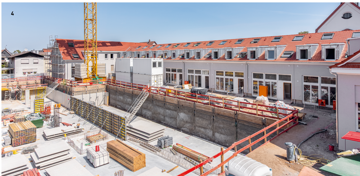
4 Die beengten Bedingungen einer Baustelle im Bestand erfordern eine ausgeklügelte Baulogistik. © Henning Krefit
