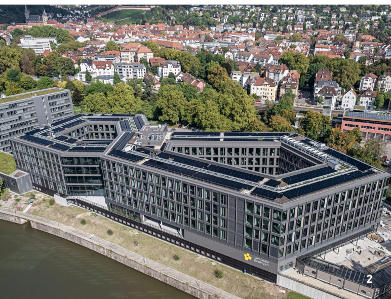
2 Neubau am Neckar: Die nachhaltige und ressourcenschonende Realisierung des neuen Landratsamts Esslingen u.a. mit R-Beton folgte einem Konzept zum kreislaufgerechten Bauen. © Ed. Züblin AG / Niels Schubert
