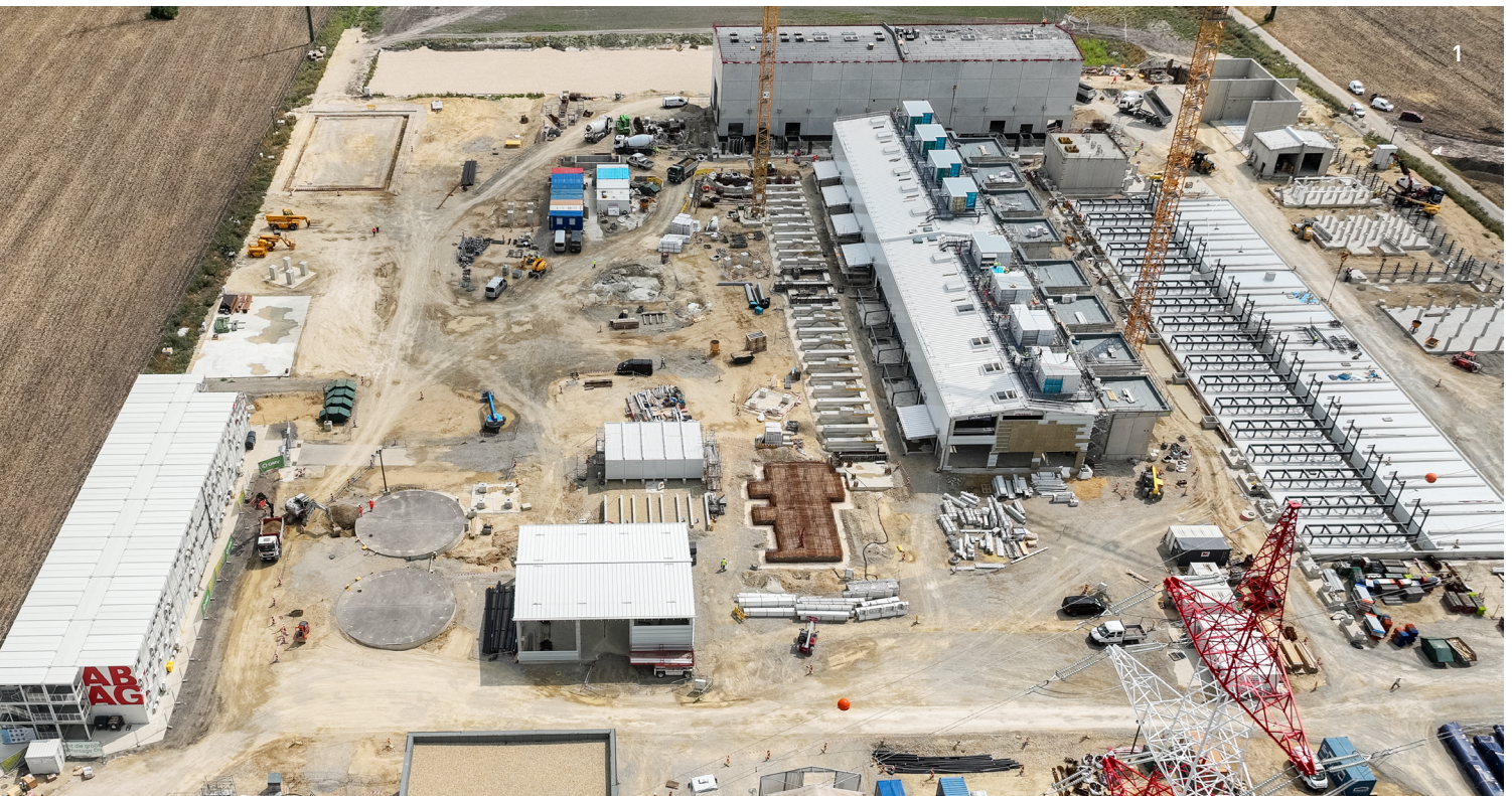
1 In Bruck an der Leitha entsteht Österreichs größte Elektrolyseanlage. © STRABAG
