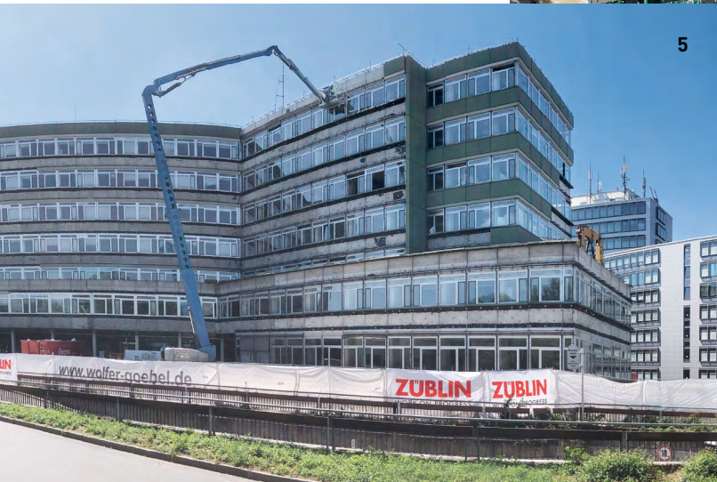
4 Der Neubau des Landratsamts wurde zu einem hohen Anteil mit Recycling-Baustoffen errichtet. © Landkreis Esslingen / 5 Mehr als 90 % der Baumaterialien aus dem Rückbau des Bestandsgebäudes von 1978 werden wiederverwertet. © Landratsamt Esslingen, Andrea Wangner
