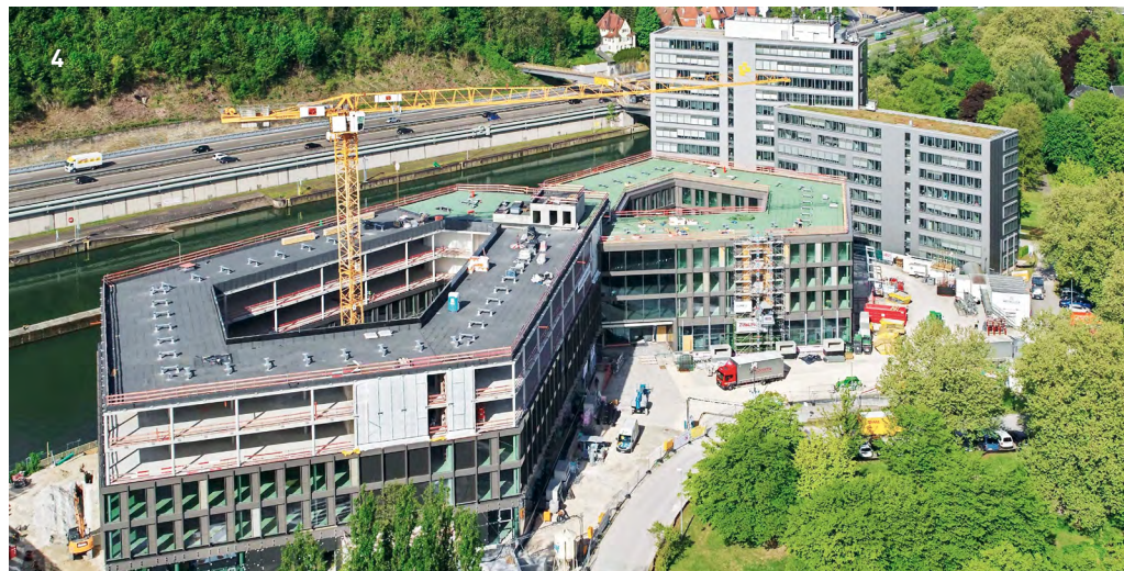
4 Der Neubau des Landratsamts wurde zu einem hohen Anteil mit Recycling-Baustoffen errichtet. © Landkreis Esslingen / 5 Mehr als 90 % der Baumaterialien aus dem Rückbau des Bestandsgebäudes von 1978 werden wiederverwertet. © Landratsamt Esslingen, Andrea Wangner
