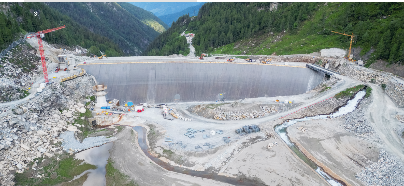
3 Der Steinschüttedamm wird um sieben Meter erhöht. © STRABAG
