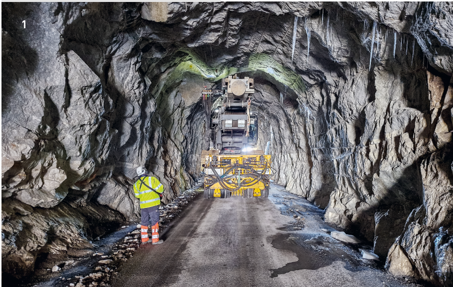
1 Baumaschinen mussten teils über enge Straßen mit starker Steigung zur Baustelle gebracht werden. © ZÜBLIN / 2 Zentimetergenaue Herstellung der Bohrpfähle. © ZÜBLIN
