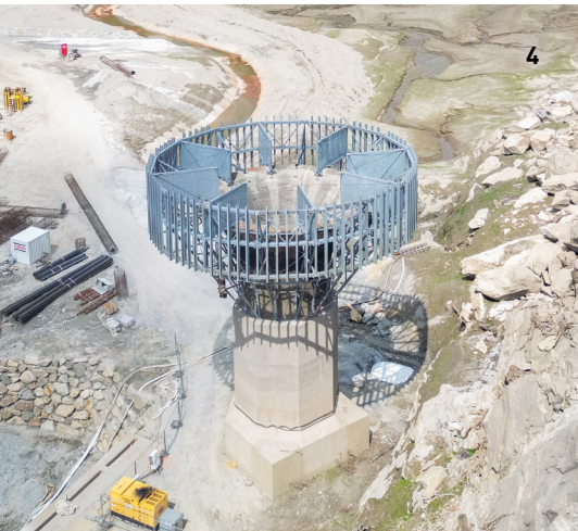
4 Der Hochwassertrichter dient zum Hochwasserschutz. © STRABAG / 5 Der Wurtenspeicher von oben. © ZÜBLIN
