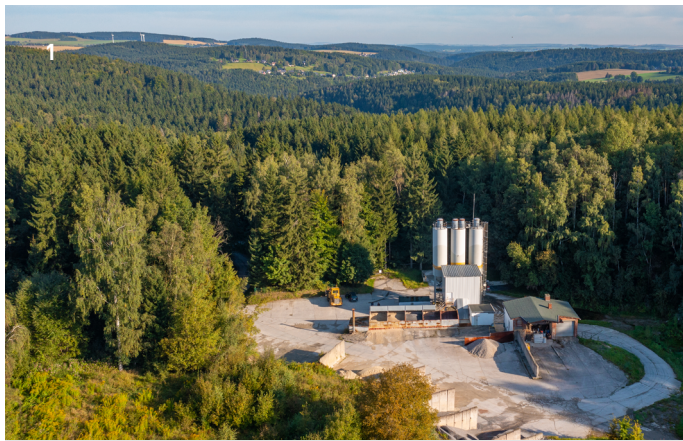
1 Betonmischanlagen der Konzerntochter ROBA Transportbeton
