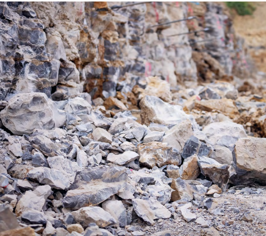
Rund 300.000 Kubikmeter Muschelkalk aus dem Karlsruher Hang werden an das nahegelegene Natursteinwerk im Nordschwarzwald (NSN) geliefert, wo es zu hochwertigen mineralischen Ersatzbaustoffen aufbereitet wird.
