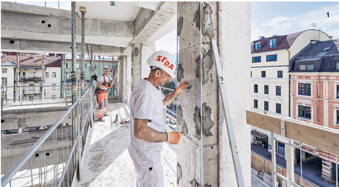
1 Das Stahlbetonskelett des ehemaligen „RLB-Turms“ ist die Basis des neuen Stadtquartiers. © STRABAG / Toni Rappersbergers
