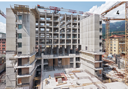
4 Die Lage der Baustelle mitten in der Stadt erforderte eine ausgeklügelte Logistikplanung. © STRABAG / Toni Rappersberger / 5 Die „herausragende“ Konstruktion verleiht dem Hammerkopf seinen Namen. © STRABAG / Toni Rappersberger
