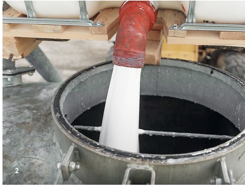
2 Das polymere Bindemittel wird individuell dosiert, mit Zement unter das Baustoffgemisch gemischt und anschließend verdichtet. © Gert Beer
