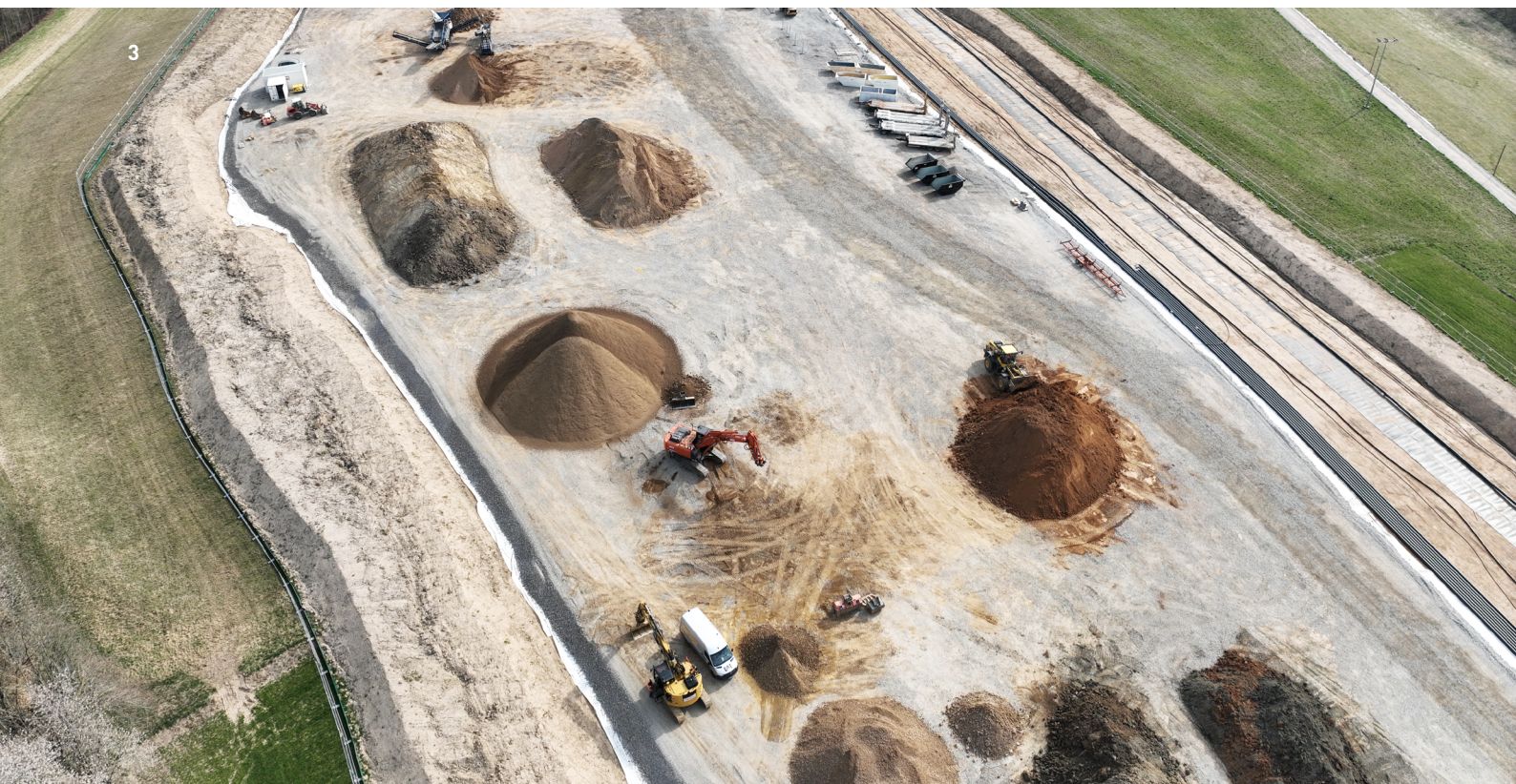
3 STRABAG trennt die ausgehobenen Bodenschichten sorgfältig und verbessert vor der Wiederverwertung zur Verfüllung der Gräben gezielt die Wärmeleitfähigkeit der rohrnahen Schicht. © STRABAG AG
