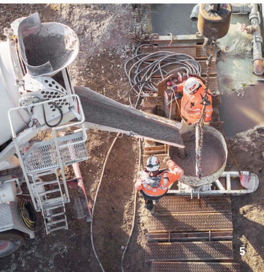
5 Für den Bau der U5 werden gezielt CO 2 -reduzierte Beton-Sorten eingesetzt – zum Beispiel mit klinkerarmem Zement. © Ed. Züblin AG, Sebastian Engels Fotografie / 6 U5-Haltestelle Sengemannstraße © Hamburger Hochbahn AG, Visualisierung: beyond visual arts / Architektur: GKKS Hamburg
