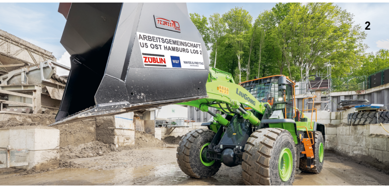
2 Für das Bodenmanagement setzt das Projektteam in Los 2 einen emissionsfreien Elektro-Radlader im Baustellenbetrieb ein. © Ed. Züblin AG, Sebastian Engels Fotografie / 3 Einhub fertig montierter Bewehrungskörbe per Kran auf der U5-Baustelle in Hamburgs Nordosten. © Ed. Züblin AG, Sebastian Engels Fotografie
