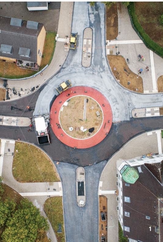
1 ClAir® Asphalt-Einbau in Dinslaken: erster Kreisverkehr mit Luftreinigungsfunktion, © STRABAG AG / Timo Lutz Werbefotografie / 2 ClAir® Asphalt auf dem Bielefelder Verkehrsknotenpunkt Jahnplatz
