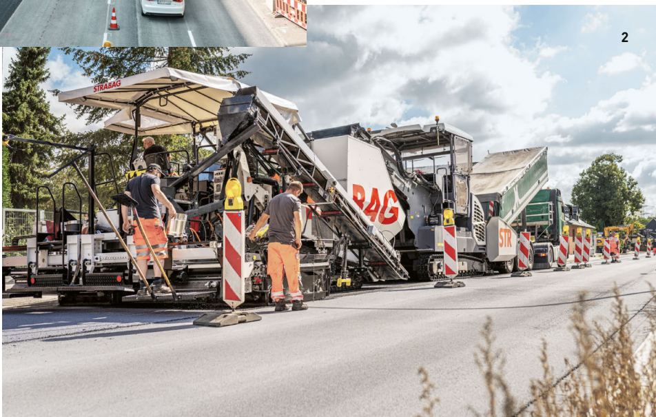
1 Pilotstrecke am Stuttgarter Neckartor © STRABAG AG / Thomas L. Fischer / 2 ClAir® Asphalt-Einbau in Dinslaken © STRABAG AG/ Timo Lutz Werbefotografie
