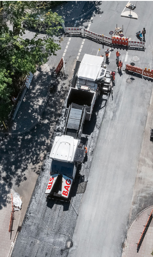
3 CIAir® Asphalt-Einbau in Erlangen / 4 Innovationsfertiger / 5 Fertigerintegrierter Streuer
