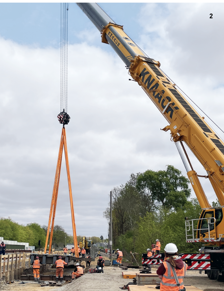
2 Einhub der Hilfsbrücken zum Start der Bauarbeiten für die U5-Haltestelle Sengelmannstraße in Hamburg durch die ARGE aus ZÜBLIN und Wayss & Freytag © HOCHBAHN
